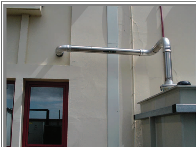
Détail entrée eaux usées de procédés dans la cuve RET1
