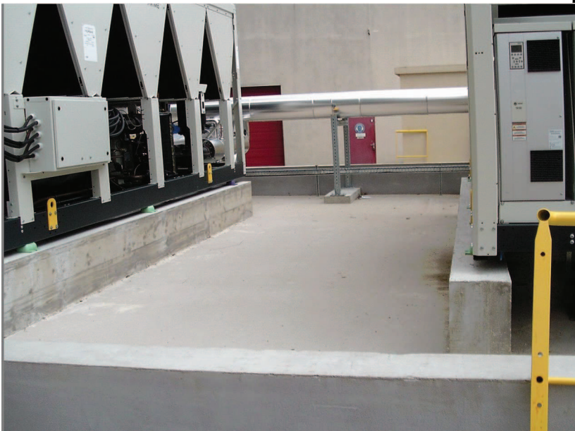
Vue détaillée de la rétention du bloc "nouveaux compresseurs".
