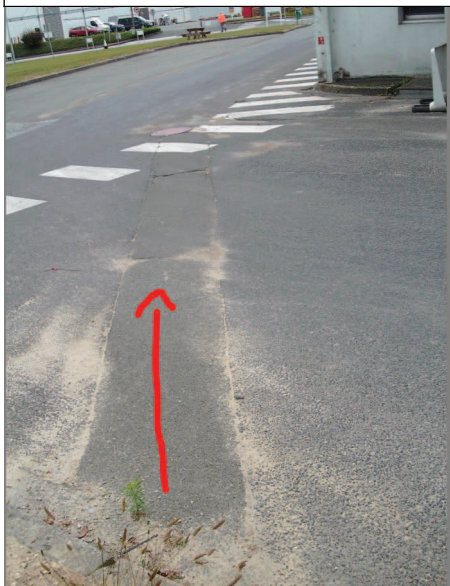
Sortie de la cuve RET6 vers la canalisation des eaux de process (le regard peint en rouge indique qu'il s'agit d'une canalisation d'évacuation des eaux de process).
