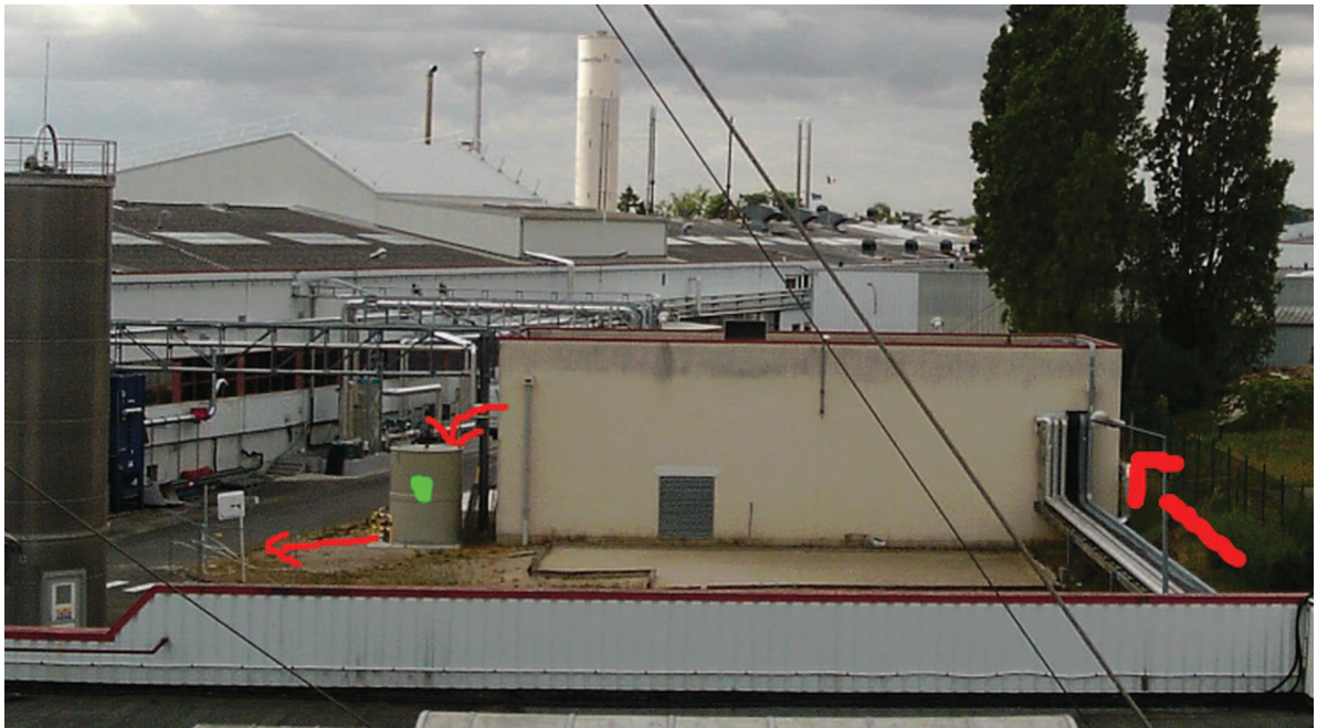
Cheminement des eaux usées de process dans le bâtiment R11 (flèche rouge), la cuve R6 est marquée en vert.
