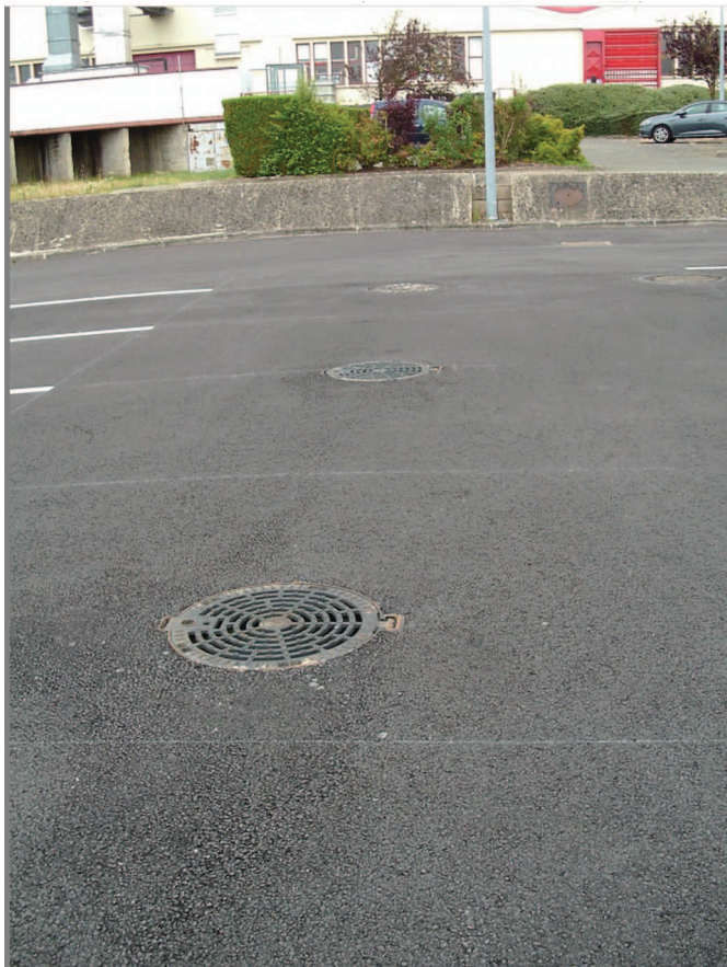
Regards correspondant aux cuves enterrées
