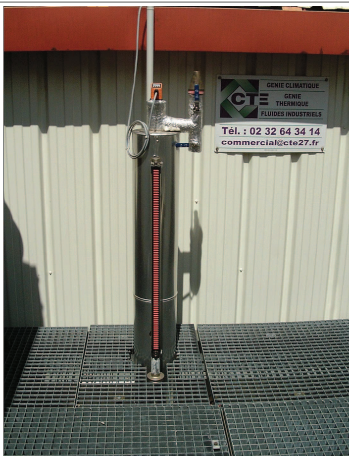
Dispositif de détection de fuite de glycol.
