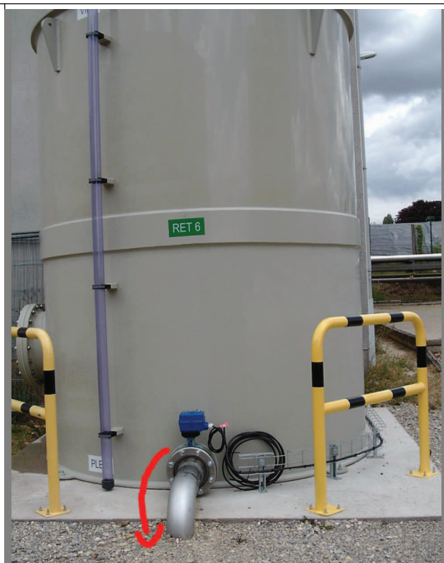
Sortie des eaux usées de process (rouge) de la cuve RET6 et électrovanne de fermeture de la cuve (boîtier bleu)
